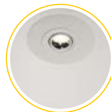
6. Новый встраиваемый потолочный светильник размещен в переходном кольце.
