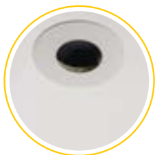
4. Переходное кольцо установлено. Большой вырез в потолке полностью закрыт.
