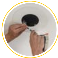
5. Электрическое подключение и монтаж нового встраиваемого потолочного светильника.
